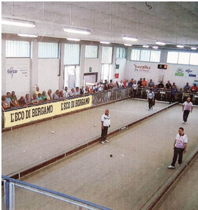
Il bocciodromo Orobico prima della ristrutturazione in corso
